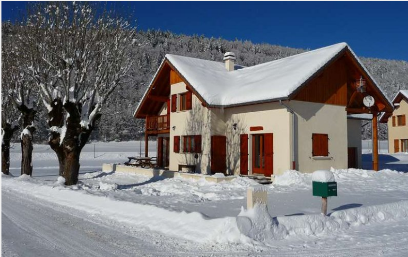
Crédit photo : Vue Sud Est de la maison (Gîtes de France)
