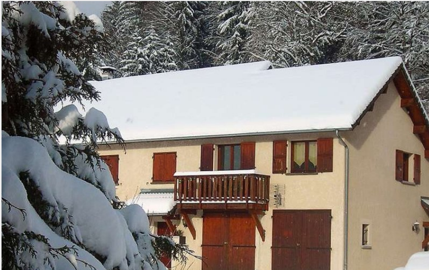
Crédit photo : Le Gîte, garage au rdc (Gîtes de France)
