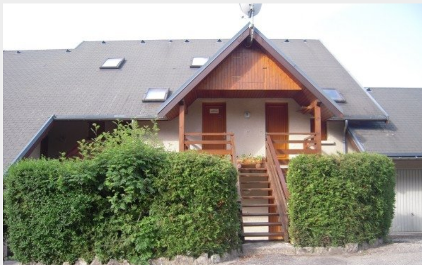
Crédit photo : Vue de l'entrée porte de gauche 1er étage ( Nord ) ( Clévances )
