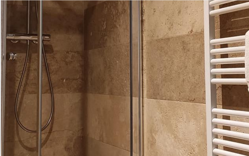
Crédit photo : Salle d'eau (Château du Poët-Célar)
